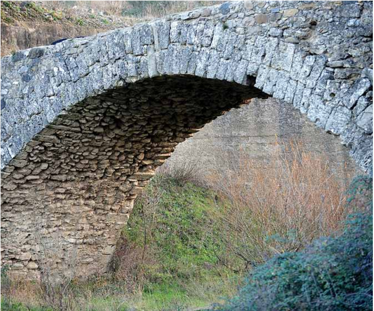
Il ponte di pietra dell'Oglio – arcata laterale (foto Mario Spagnuolo)
